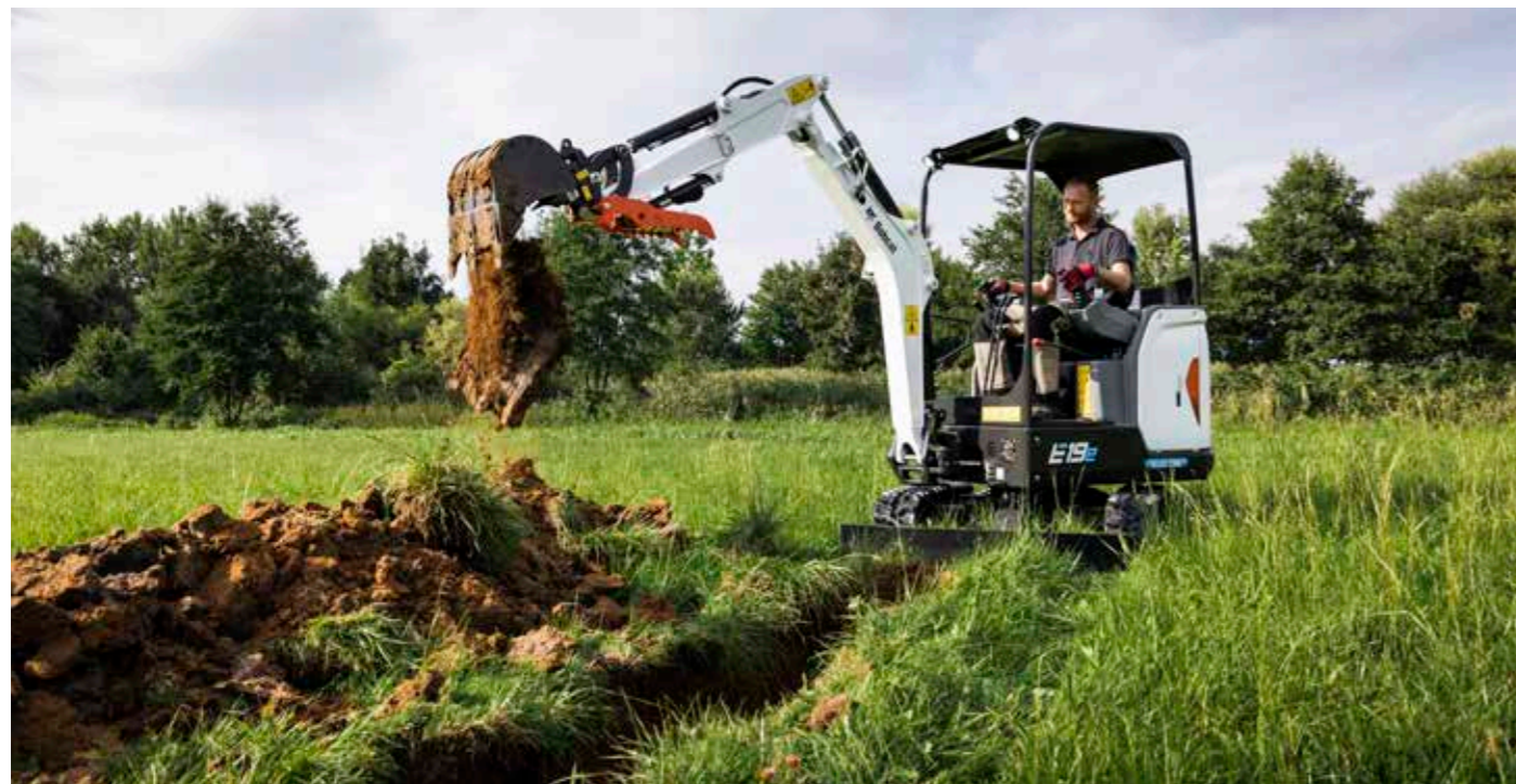
Trenching with the E19e
